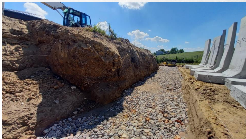
Rys. 3a. Warstwa podbudowy z kruszywa
